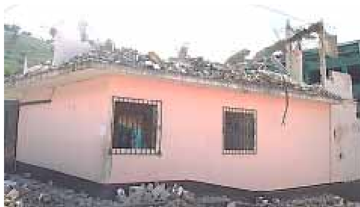
Figura 08. Colegio colapsado en horas de clase.
