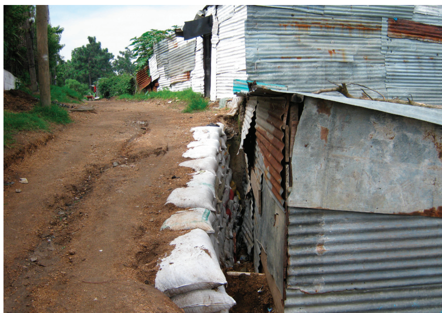
Figura 3: Valle es de La Arenera Zona 21. (s.f) Ciudad de Guatemala Por: Rosa Sánchez (fotógrafo)
