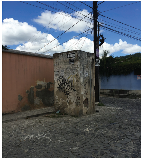
Figura 3. Caja de agua - acueducto Pamputic, 7 Avenida Poniente. Fotografía: Frinee Estrada 2016
