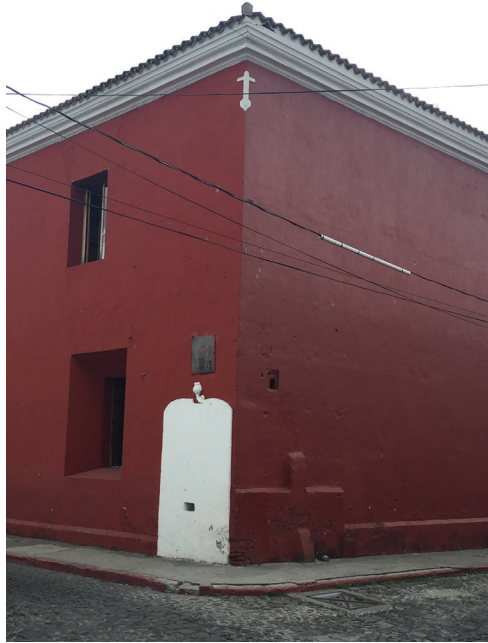
Figura 4. Caja de agua- acueducto Pamputic, 3 calle Poniente. Fotografía: Frinee Estrada 2016
