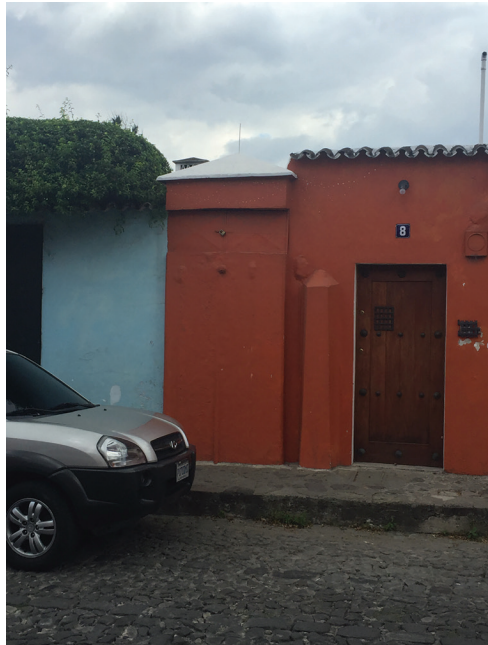
Figura 5. Caja de agua- acueducto Santa Ana, 3 avenida Sur. Fotografía: Frinee Estrada 2016
