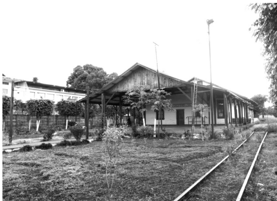
Figura 3: estación del ferrocarril y vía férrea. Fotografía por Evelyn Mejía, 2015.
