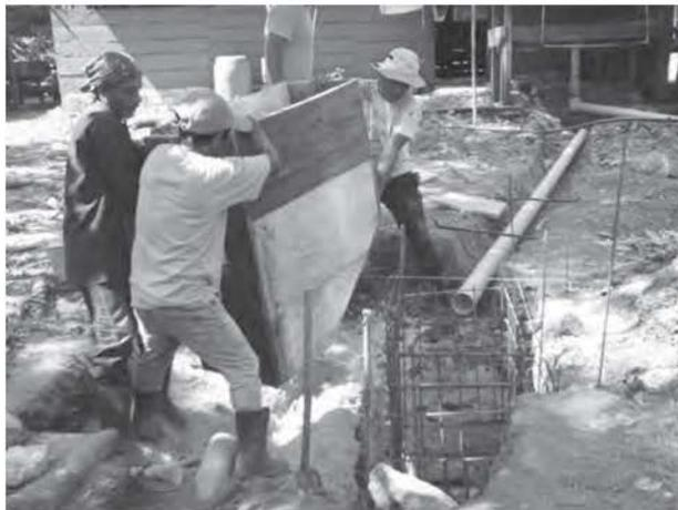
Figura 1: proceso de construcción de trampa de grasas
