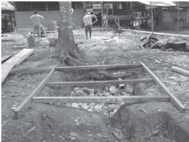
Figura 3: detalle de pozo de absorción para la disposición de aguas residuales
