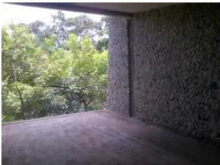
Figura no.11 construcción de paredes
