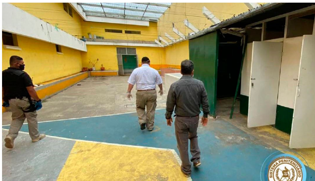
La imagen proyecta el deterioro de la infraestructura en el centro preventivo de la zona 18. (Fotografía Dirección General del Sistema Penitenciario).
