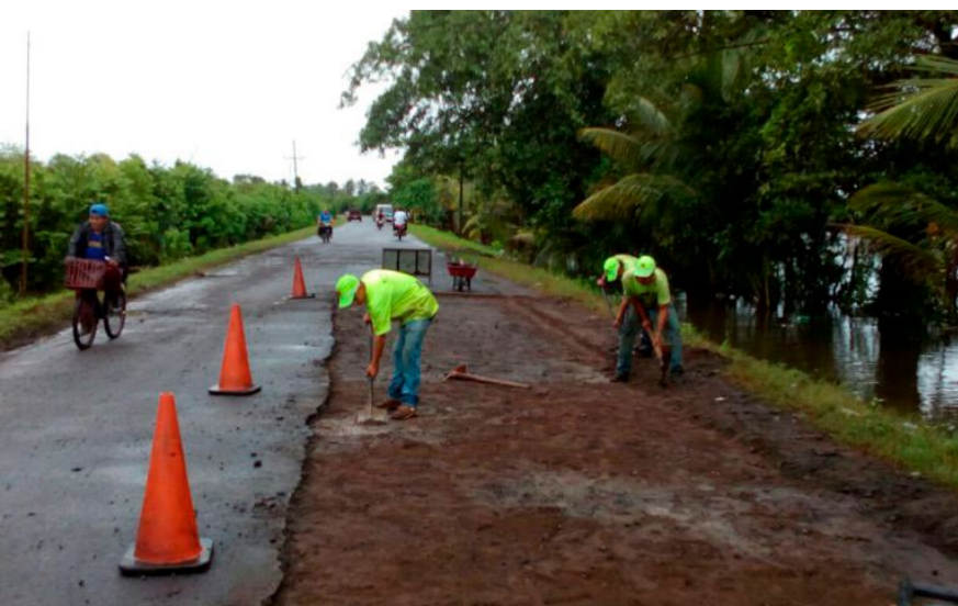
Foto: Mantenimiento de carretera
