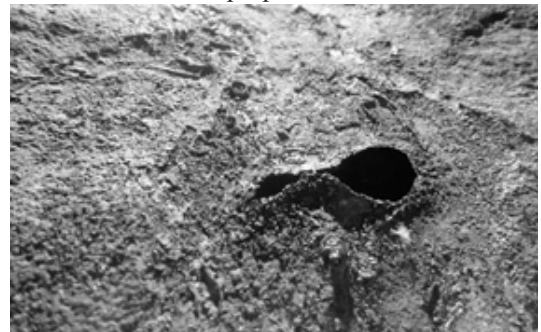
Figura 4. Perforación. Fuente: elaboración propia.
