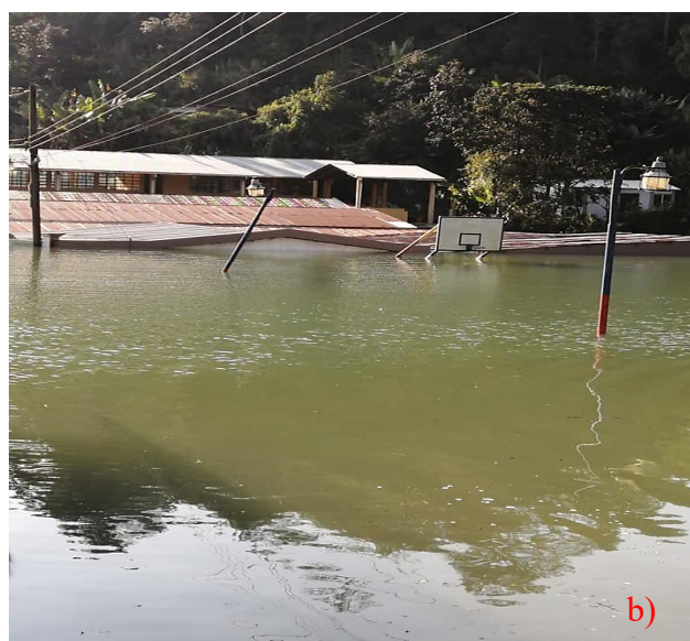
Figura 1. a) Altura máxima de inundación provocado por las tormentas Iota y Eta, en el establecimiento de Panaha del municipio de San Cristóbal. b) Inundación dentro del área de la escuela Chitúl, Santa Cruz Verapaz. (SOY1602 Santa Cruz Verapaz Noticias, 2020).
