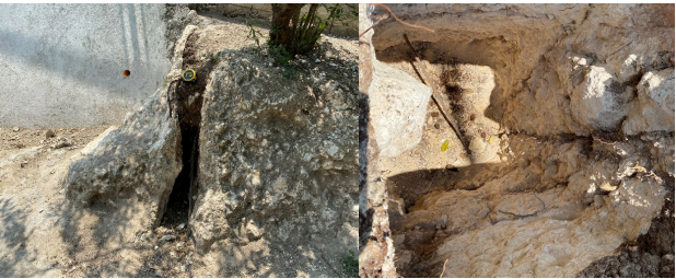
Figura 3. Características del patrón de fracturamiento dentro de la costra de caliche. Fracturas con aberturas que van desde los 2, 14 y 20cm, por ejemplo, fotografía a la izquierda. Dicha grieta se encuentra rellena de suelo orgánico.
